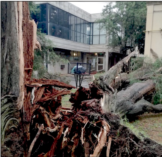
Daños en el predio de la Facultad de Veterinaria (Gentileza de la Lic.Irene Barnatán). Los rastros de su pasaje por el Barrio de Belgrano se observó en los topes seccionados de las tipas de la Av. Olleros
